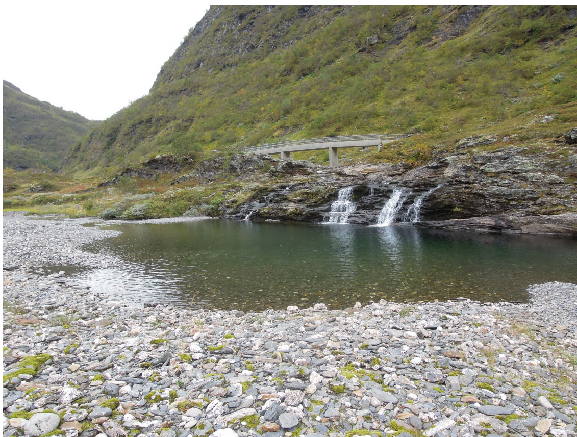
Figur 3.5. Ygnisdalselvi ca. 800 m nedstrøms planlagt inntak
