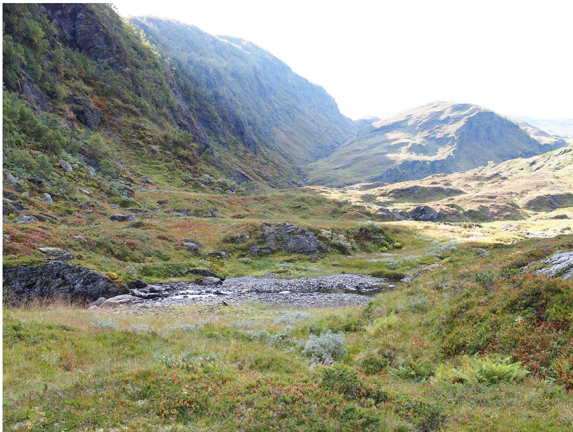
Figur 3.4. Ygnisdalselvi ved inntaksdammen
